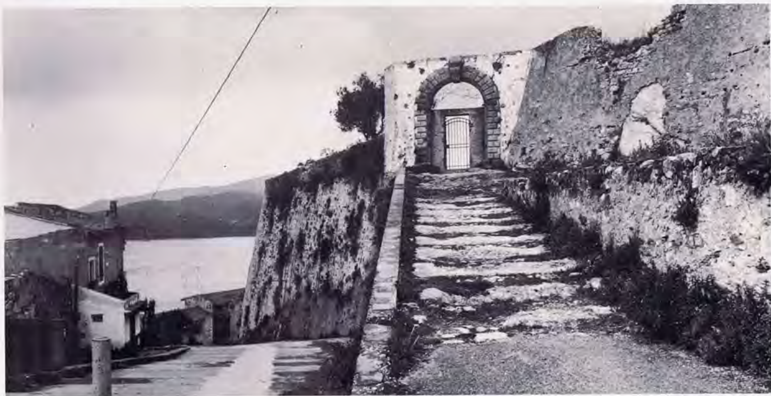
89 - Accesso al Bastione delle Palle da Via della Regina.
